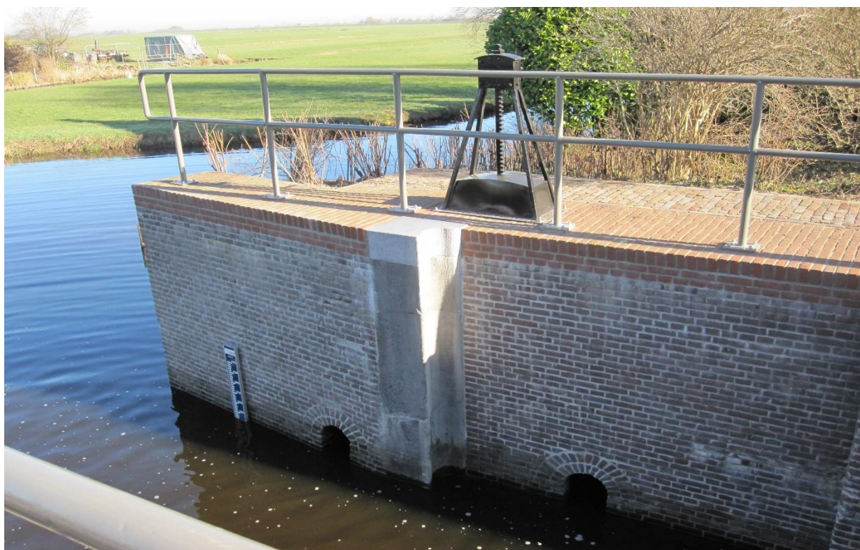
De tandheugel voor de bediening van de waterschuif is op de oude plek teruggezet
